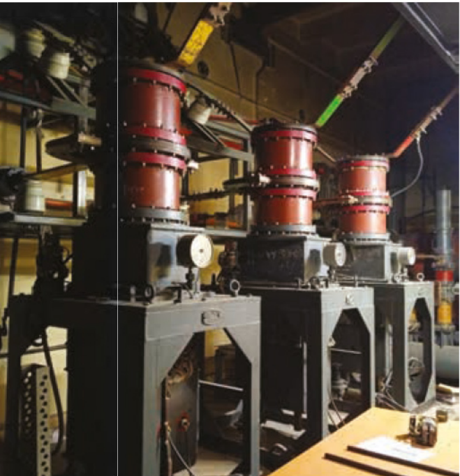
Рис. 2. Включающий аппарат ВА-12 в составе ЛБМ
