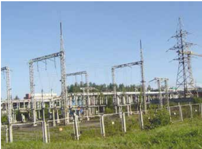
Рис. 1. Внешний вид ОРУ 110 кВ
