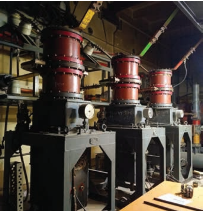
Рис. 2. Включающий аппарат ВА-12 в составе ЛБМ
