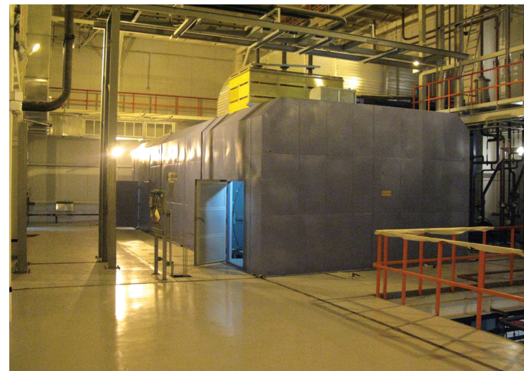
Рис. 3 Асинхронизированный компенсатор АСК-100-4 на ПС 500 кВ «Бескудниково» (www.eepir.ru, декабрь 2014 г.)
