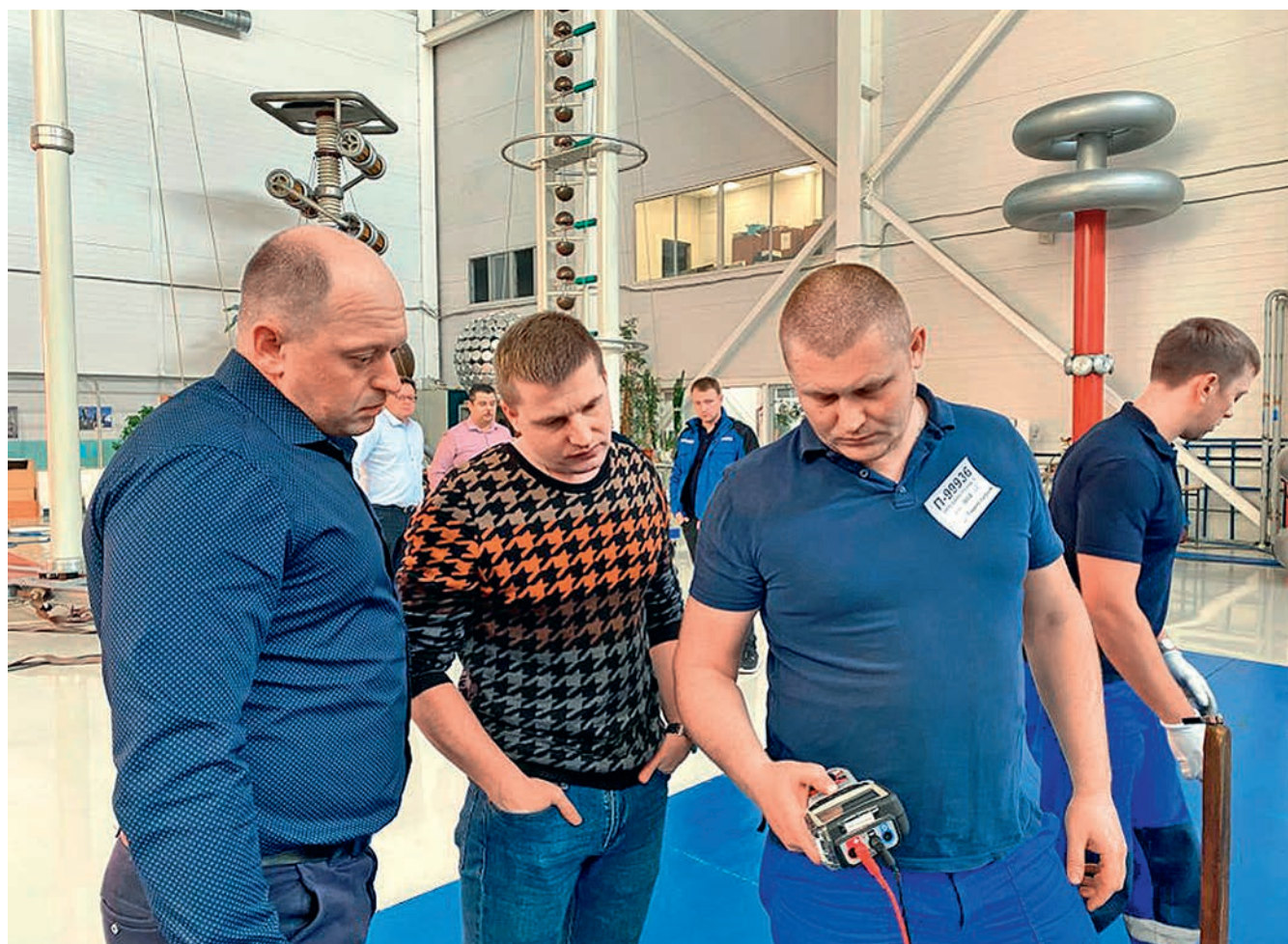
Ведущий инженер электрического цеха Ростовской АЭС Сергей Падун (слева) и главный эксперт Центрального филиала АО «ВО «Безопасность» Сергей Семочкин (в центре) инспектируют испытания высоковольтных вводов «Изолятор»
