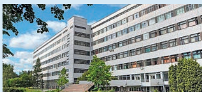
Здание Российского федерального ядерного центра — Всероссийского научно-исследовательского института экспериментальной физики в г. Сарове (фото: Научный портал «Атомная энергия 2.0»)
