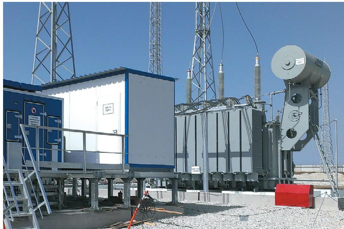
Современный управляемый шунтирующий реактор трансформаторного типа (УШРТ)
