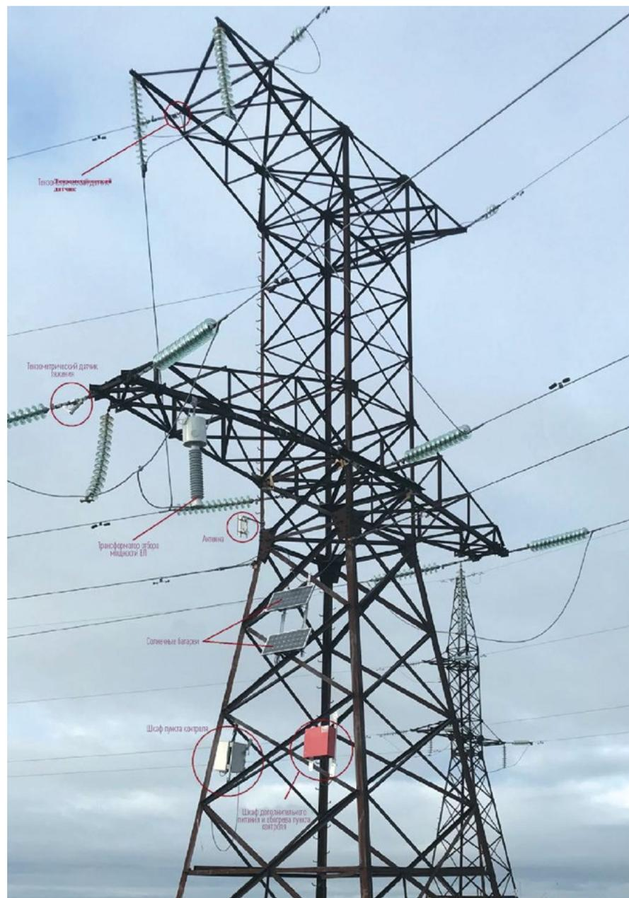
Рис. 3 Система мониторинга, установленная на анкерно-угловой опоре на Тазовском полуострове Ямало-Ненецкого АО
