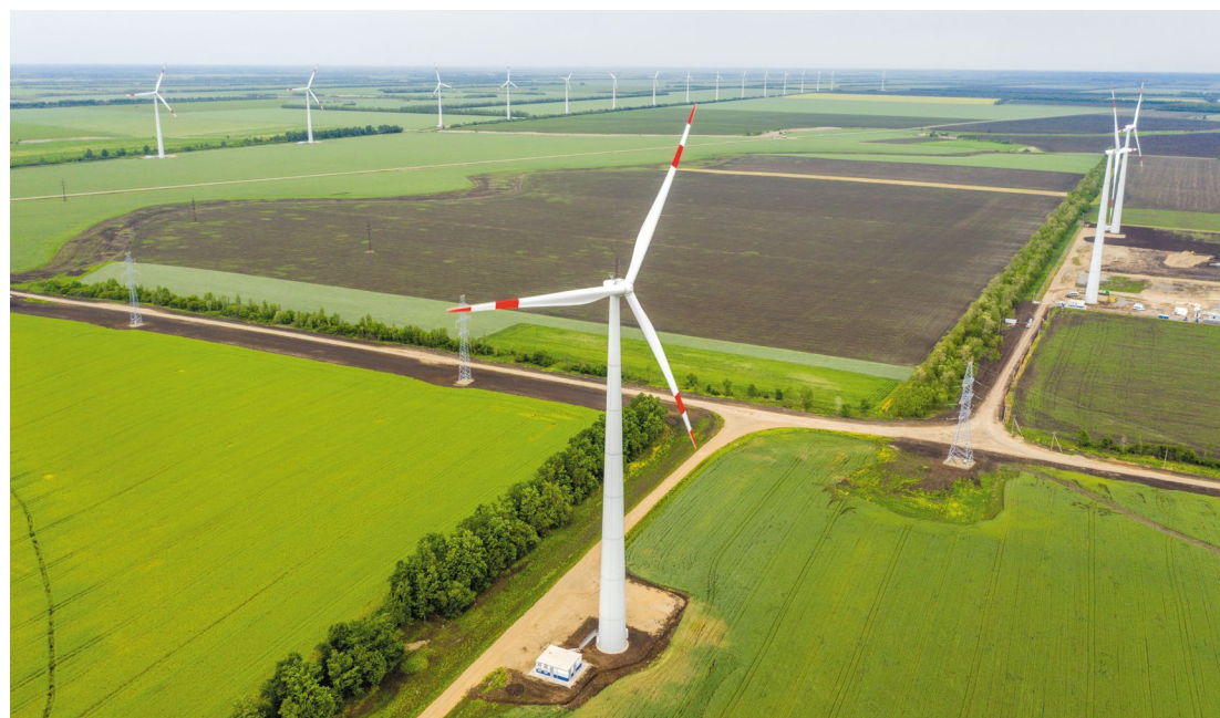
Ветряные электростанции в Адыгее
