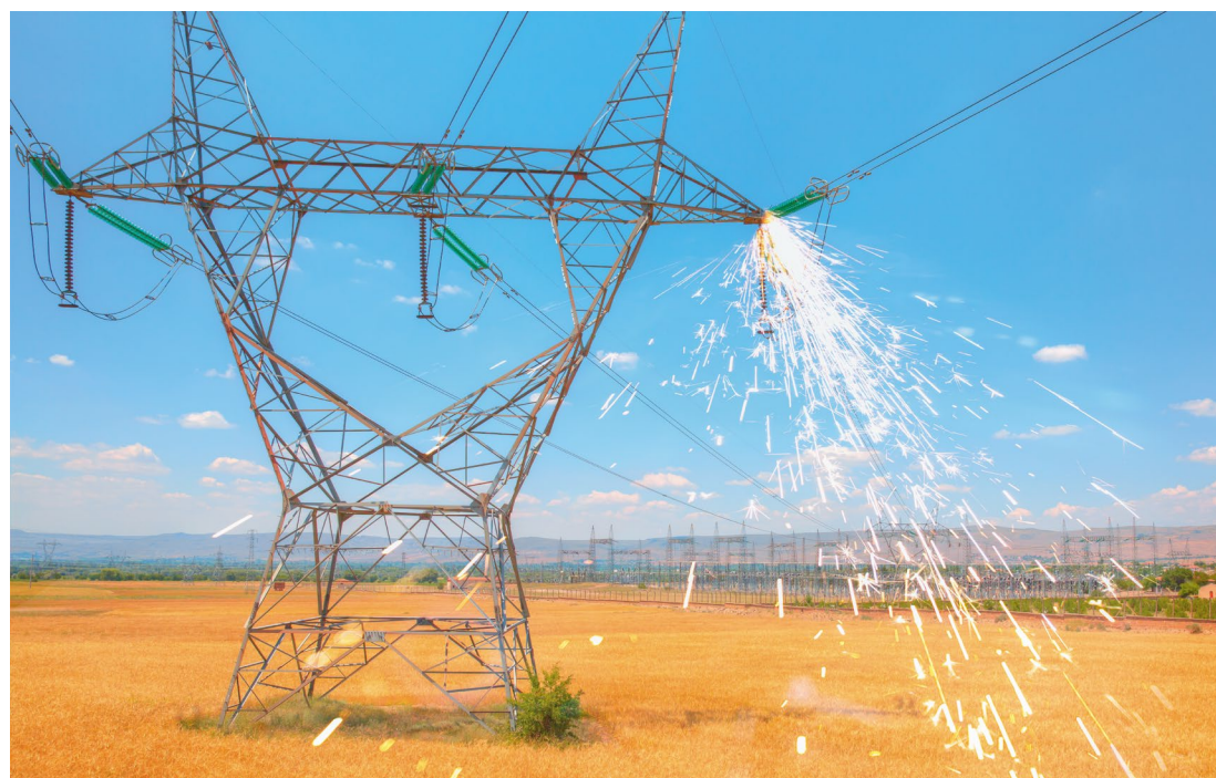
Превышение аварийно-допустимых токовых нагрузок на линиях ЛЭП приводит к аварии
