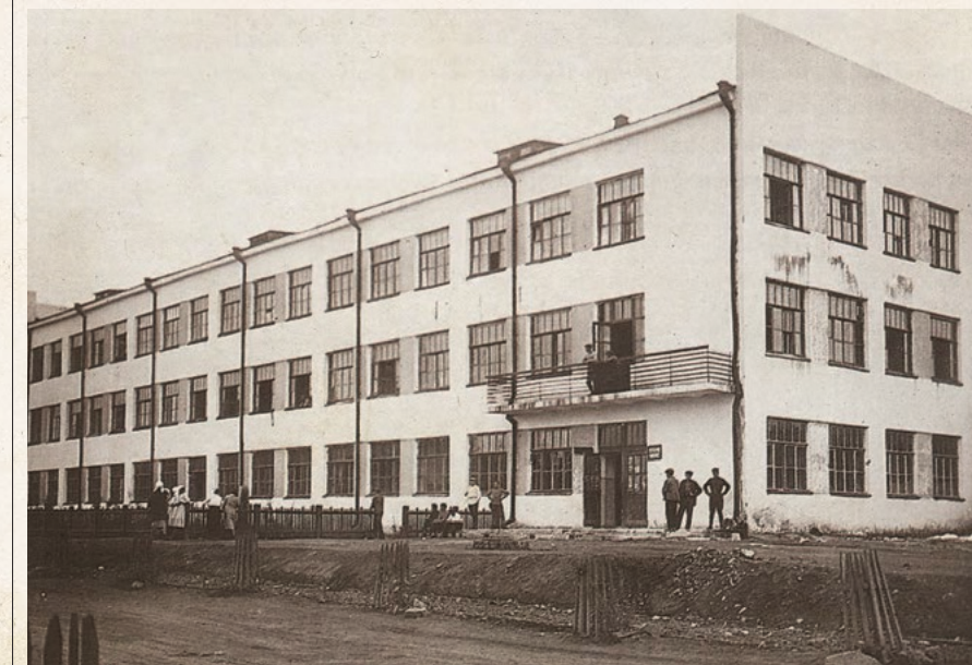
Рис. 3 Здание наркомата. Челябинский энерготехникум
