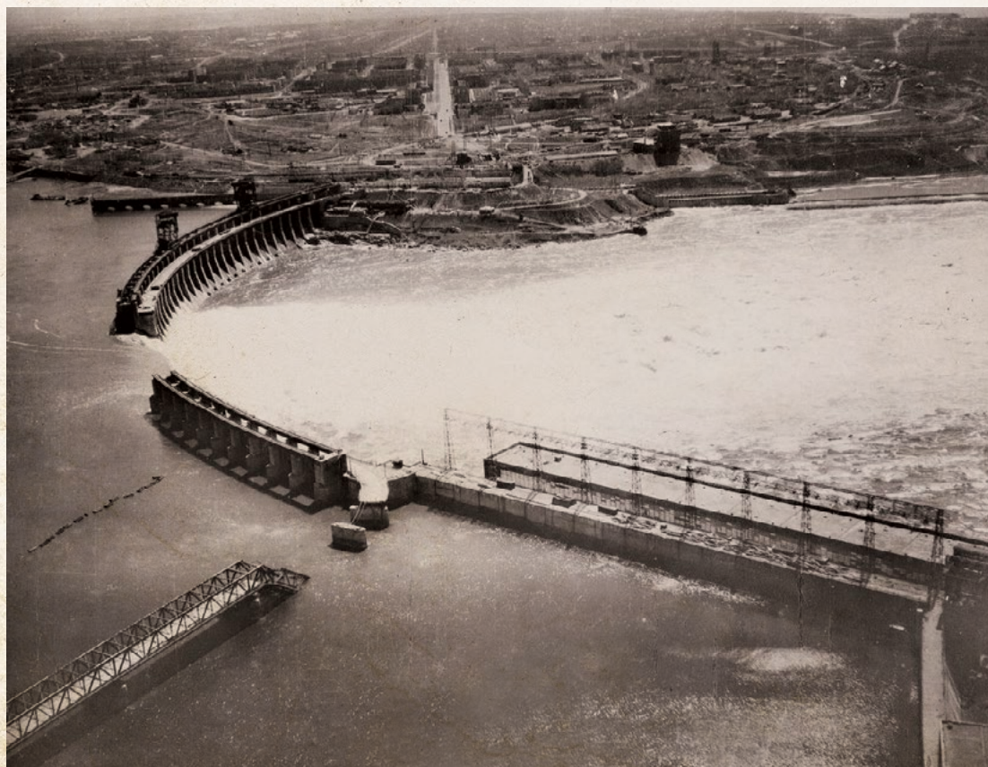
Разрушенная плотина ДнепроГЭС
