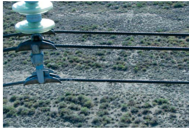
Рис. 2 Изолирующая подвеска ВЛ 500 кВ «Агадырь — ЮКГРЭС»
