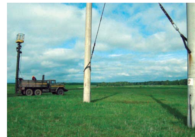
Рис. 3 Подготовка к верховому осмотру на опоре ВЛ 500 кВ «Кокшетауская — Аврора»
