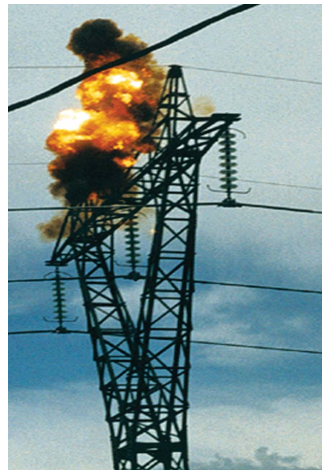
Рис. 2 Однофазное замыкание на землю ВЛ 110 кВ во время проведения натуральных испытаний, которые могут быть исключены вследствие применения ЦТМК
