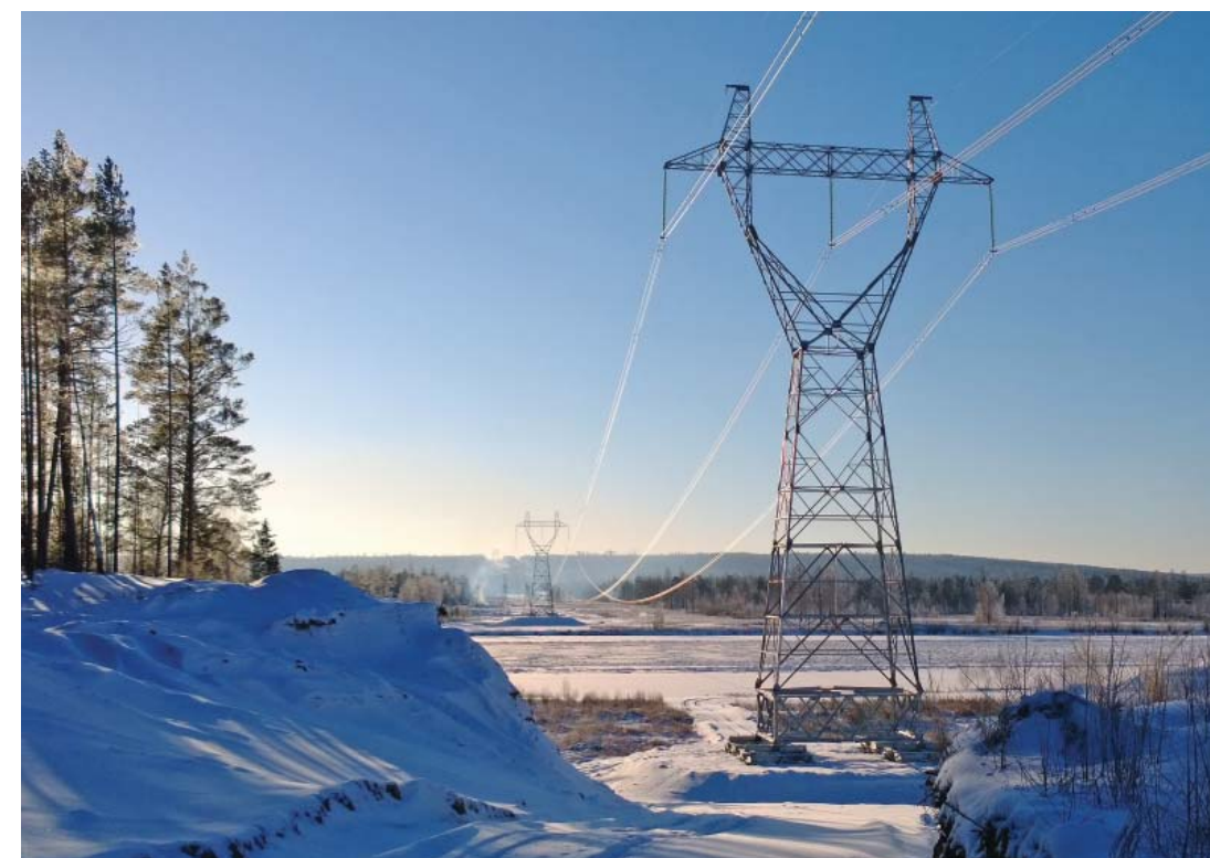
Рис. 1 Линия электропередачи 500 кВ «БогЭС — Озерная»
