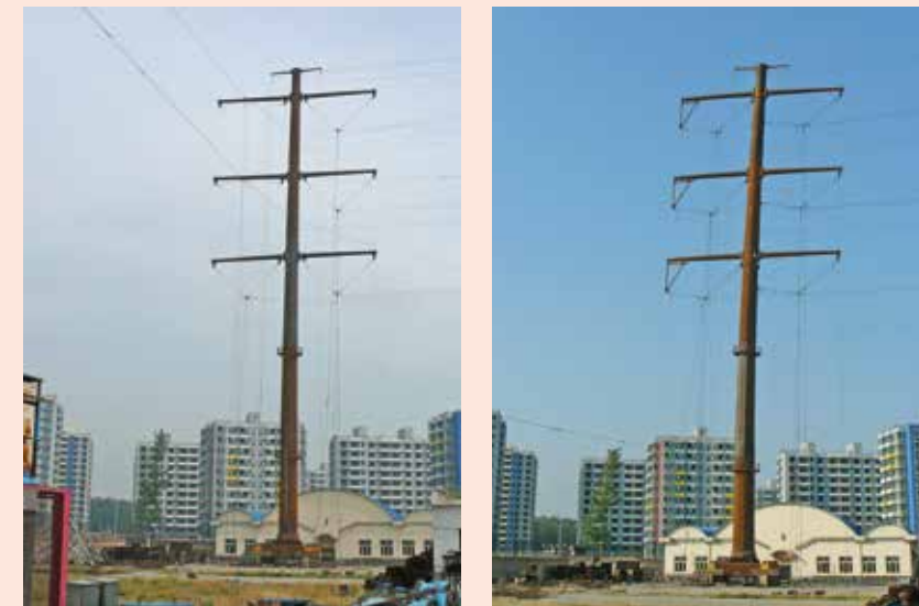
а) двухцепная промежуточная опора высотой 65 м
