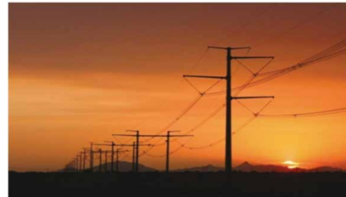
Рис. 3 Одноцепная опора 500 кВ высотой 65 м
