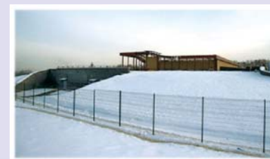
а) общий вид подземной подстанции
