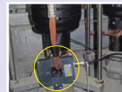
б) КЛ в изоляции из сшитого полиэтилена
