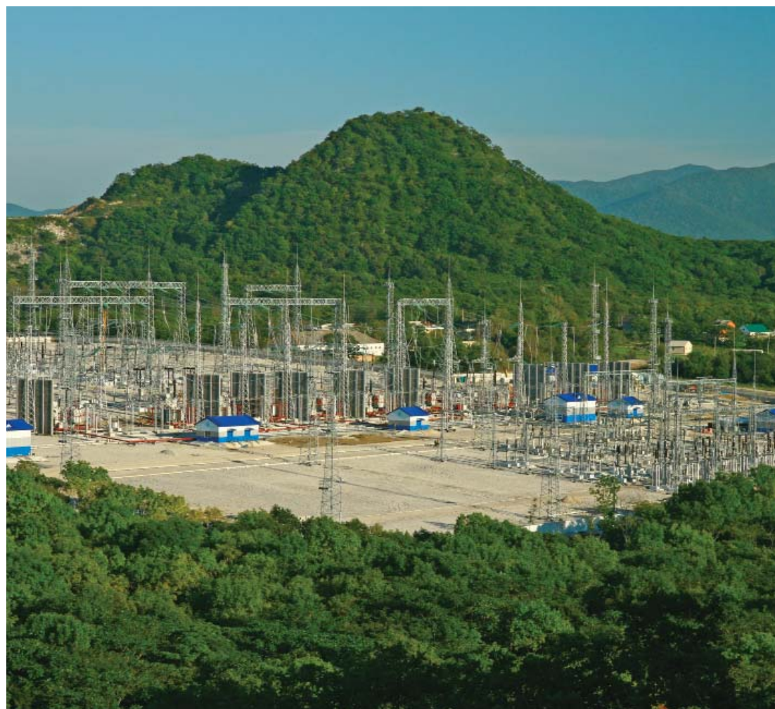
Общий вид ПС 500/220 кВ «Лозовая». На переднем плане место для расширения ПС со строительством ОРУ 110 кВ
