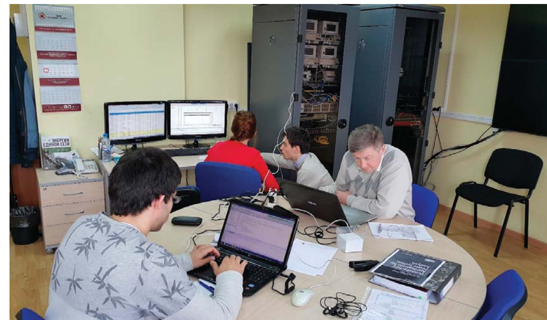
Рис. 6. Проведение комплексных испытаний опытного образца ПТК САУ НРМ на Полигоне ИЭС ААС
