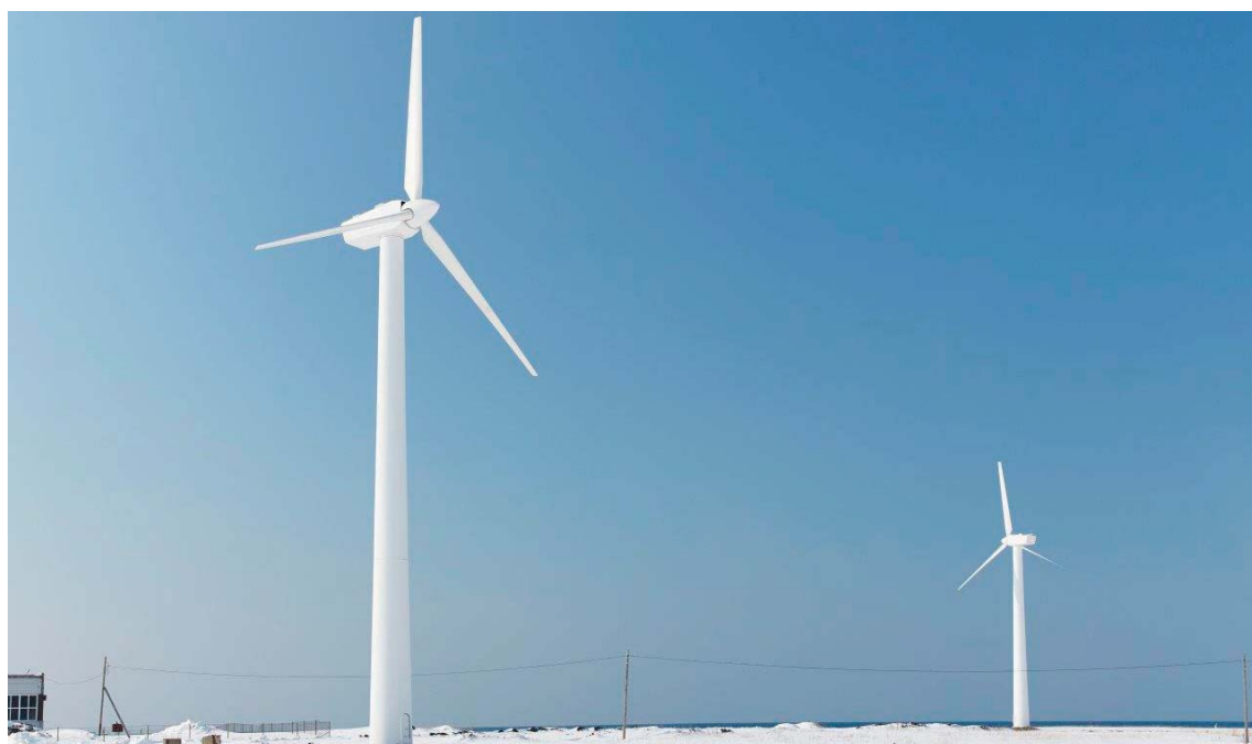
Рис. 4. ВДК в с. Новиково (Сахалинская область)
