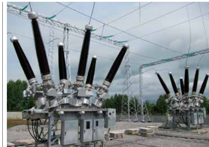
На фото: ПС Амур, Амурская область 6 x ЗАР1 DTC - 126 4 x ЗАР1 DTC - 245
