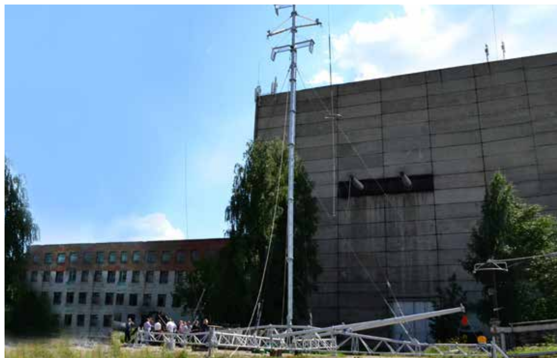
Общий вид опоры ПБМ110-1т
