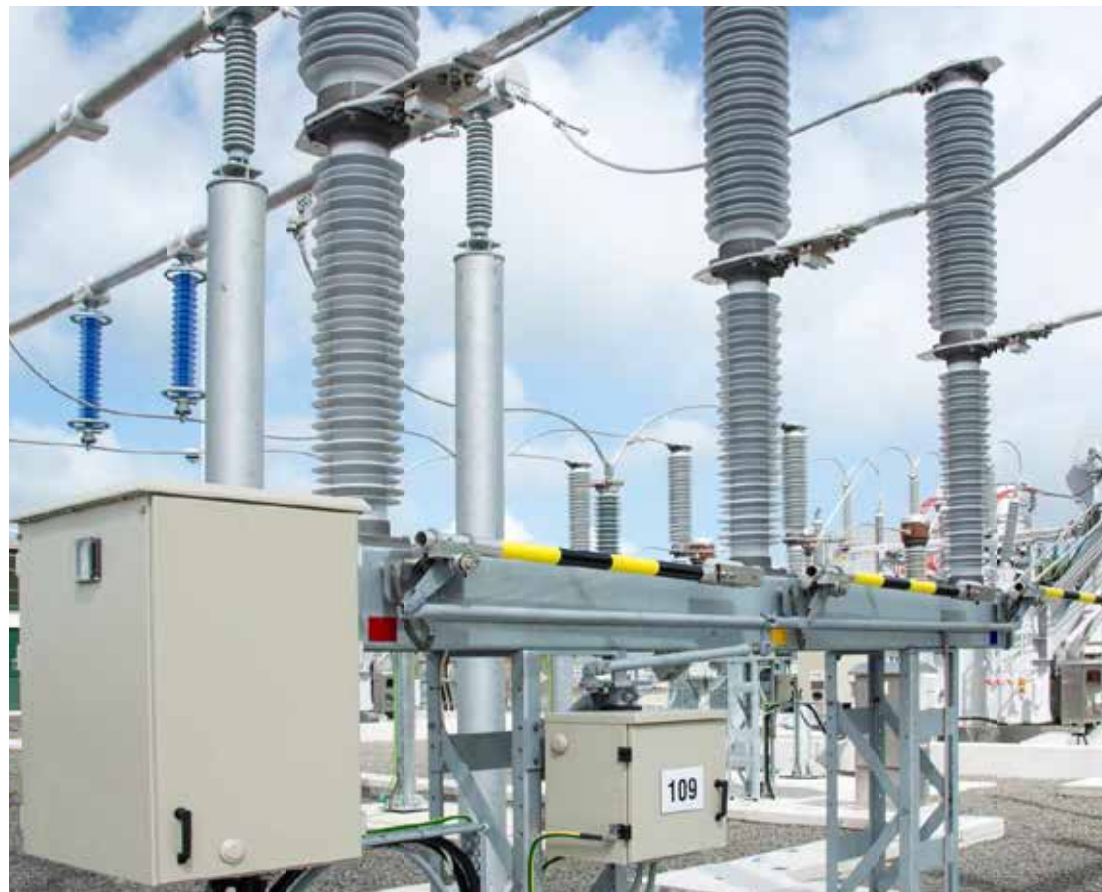
Выключатель-разъединитель фирмы ABB
