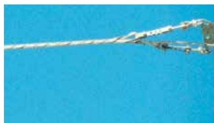
Рис. 7. Смонтированный на концевой опоре натяжной подвес спирального типа с двумя силовыми прядями
