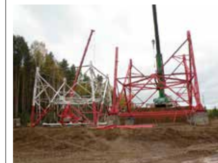
Рис. 5. Монтаж опоры перехода ВЛ 220 кВ Пермская ГРЭС – Соболи-1, 2 через Камское водохранилище
