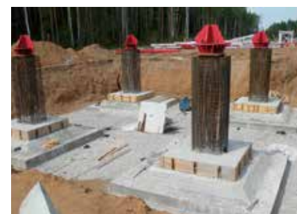
Рис. 4. Монолитный железобетонный фундамент для закрепления опоры перехода ВЛ 220 кВ Пермская ГРЭС – Соболи-1, 2 через Камское водохранилище
