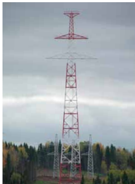
Рис. 6. Опора ПП330-2/79,5К на правом берегу перехода через Камское водохранилище
