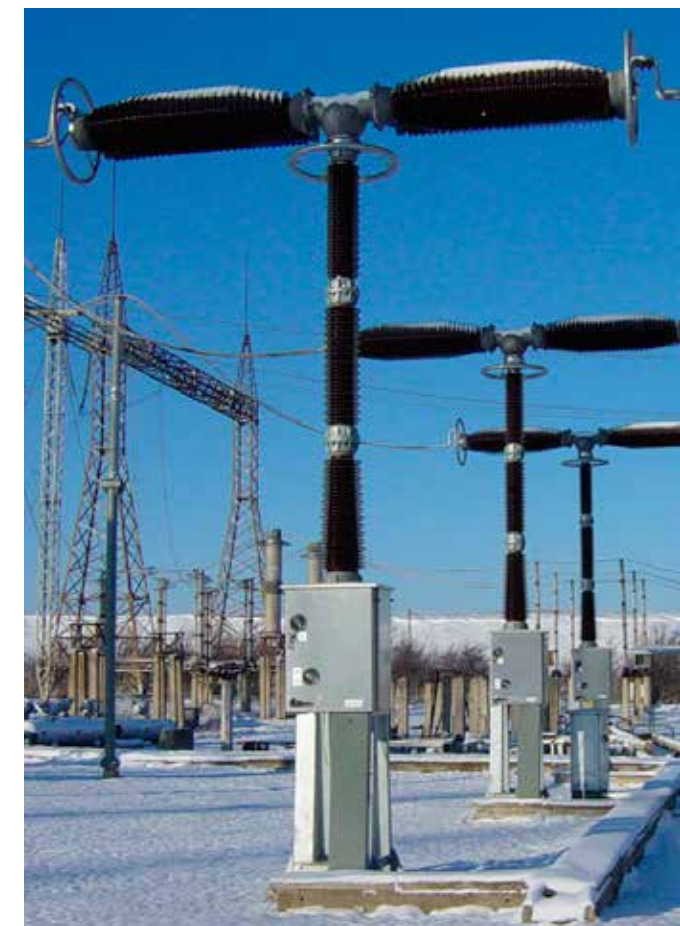
Рис. 2. Элегазовый колонковый выключатель при низких температурах заполняется смесью газов
