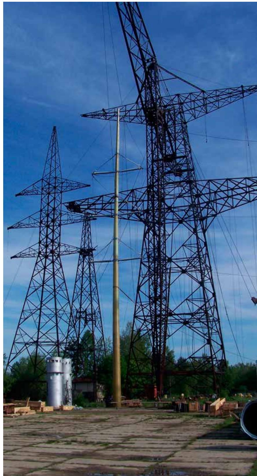
Рис. 4. Общий вид опоры перед испытаниями
