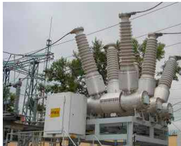
Рис. 1 Подогреваемый баковый выключатель 110 кВ производства ОАО «Уралэлектротряжмаш»
