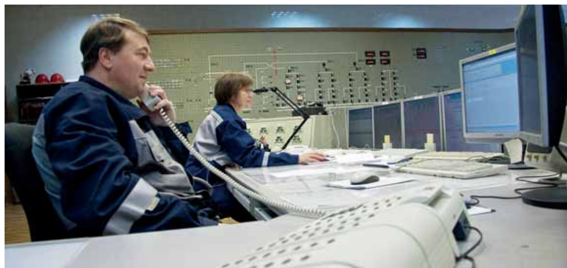
ПС 400 кВ «Выборгская»
