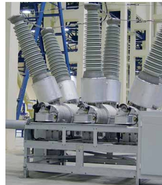
Рис. 1. Элегазовый баковый выключатель 110 кВ
