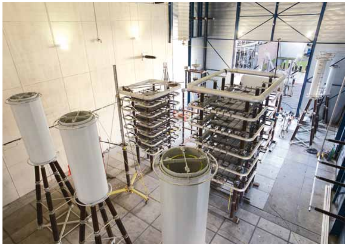
Рис. 12. Новая установка синтетических испытаний КЕМА (третья) для испытаний при ультравысоком напряжении и трехфазных синтетических испытаниях выключателей
