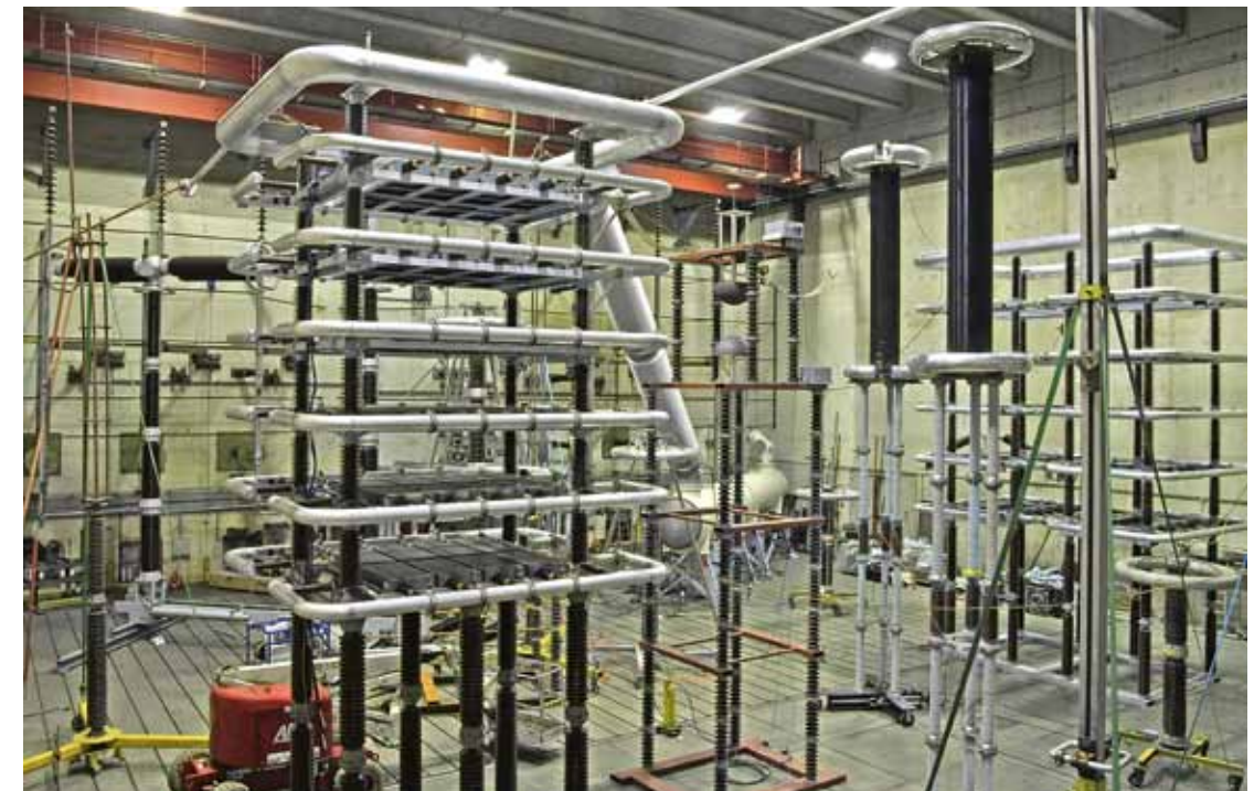
Рис. 11. Испытания выключателя 1100 кВ в КЕМА с использованием мобильной установки для двухэтапных синтетических испытаний, тестирующая сборка второго этапа установлена в испытательной камере
