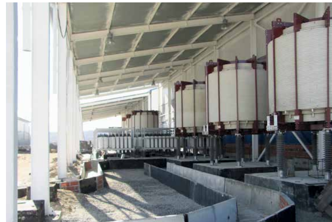
Рис. 4. Одна из стадий монтажа блока СТАТКОМ на ПС 220 кВ «Могоча»
