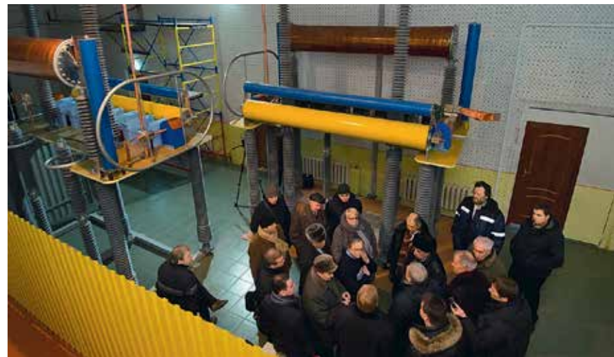
Рис. 6. Посещение специалистами ОАО «ФСК ЕЭС» площадки по испытаниям ТОУ-220 в ШФ ОИВТ РАН
