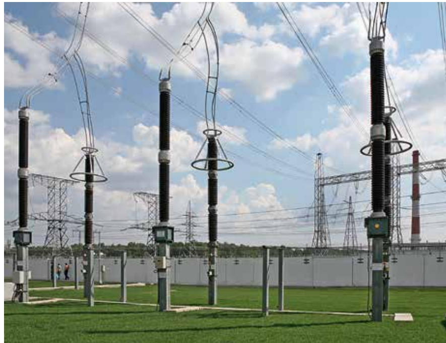
В России за период 1997–2007 гг. зарегистрирован 101 случай повреждений нелинейных ограничителей перенапряжений 110–500 кВ, установленных по схеме «фаза-земля»
