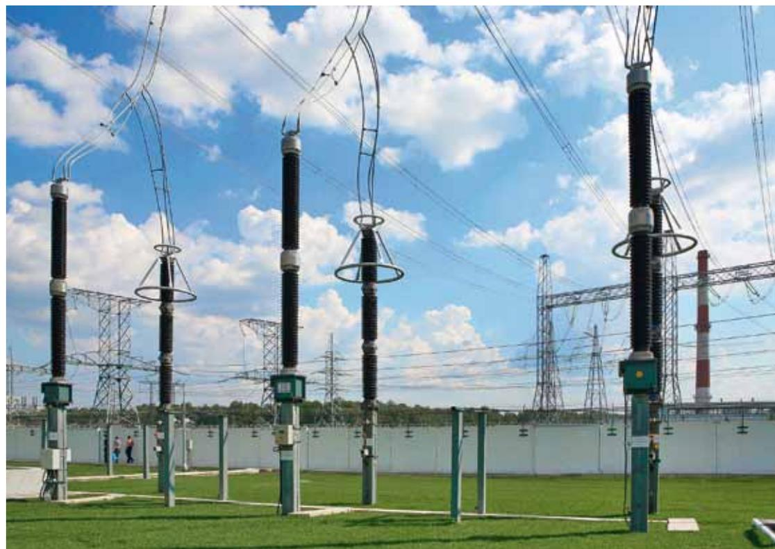
ОПН – основной аппарат для защиты электрооборудования электрических сетей от грозовых и коммутационных перенапряжений
