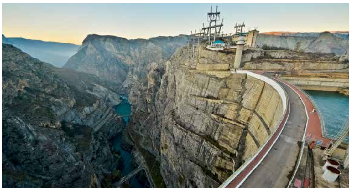
Чиркейская ГЭС – 2. Плотина ГЭС – максимальная высота 233 м, длина по оси гребня 338 м
