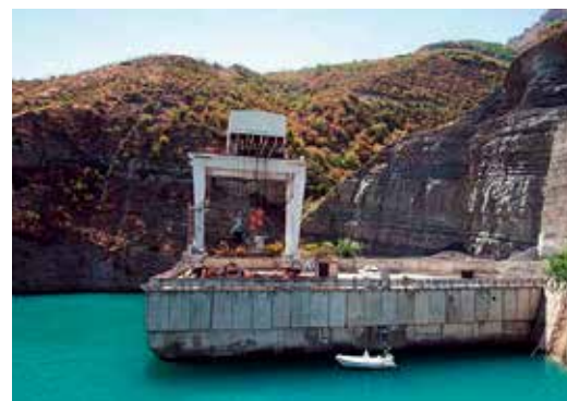
Миатлинская ГЭС (водоприемник)
