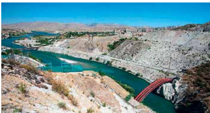
Миатлинская ГЭС (арочный переход водопада на Махачкалу и Каспийск)
