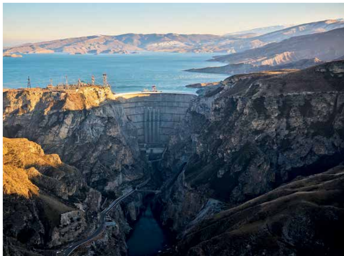
Чиркейская ГЭС в Республике Дагестан входит в состав Сулакского каскада ГЭС. Установленная мощность ГЭС 1000 МВт. Среднегодовая выработка 2,47 млрд кВт-ч. Плотина ГЭС – самая высокая арочная плотина России, максимальная высота 233 м
