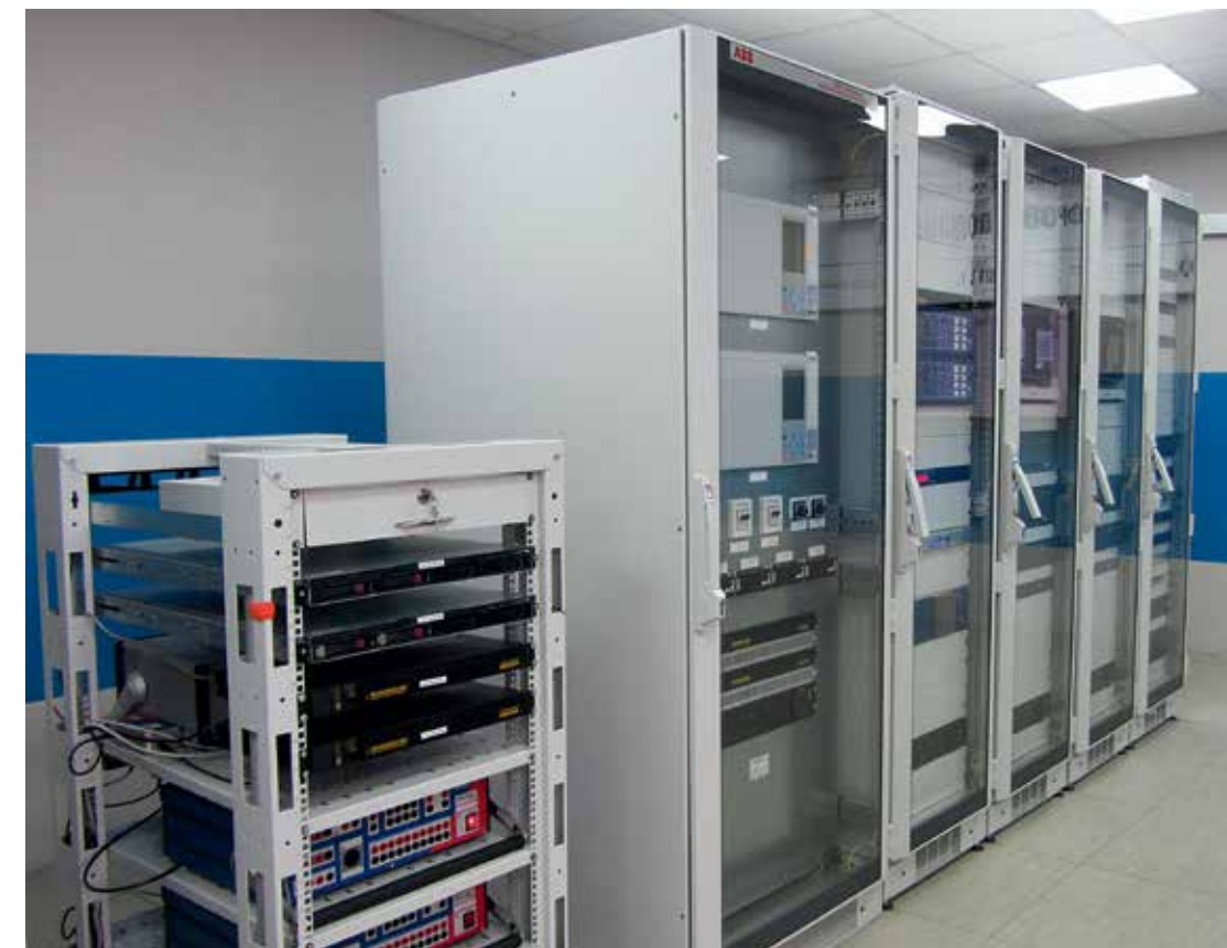
Экспериментальная цифровая подстанция (ЦПС) укомплектована интеллектуальным вторичным оборудованием, работающим на едином стандартном протоколе обмена информацией IEC 61850
